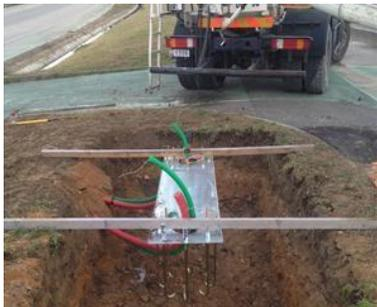
après DICT, réalisation des fouilles et des fondations, mise en place gabarit déchets amenés en décharge
