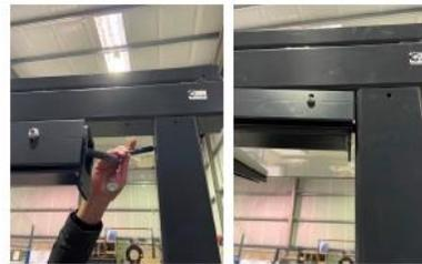
Positionner les 2 vis /poteau sans les serrer au maximum.
