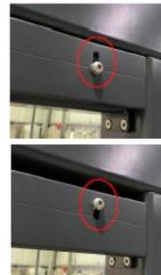
Les traverses alu sont équipées de trous oblongs permettant un serrage de l'ensemble vitres entre traverses, comme le sous-basement bois.
