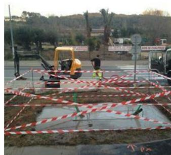
scellement des ancrages temps de séchage respecté, sécurisation du chantier
