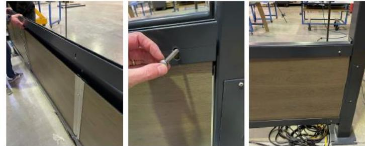
Dans la traverse alu remise en place, insérer 12 cales de vitrage pour les glaces de fond (2 par vitre, soient 6 vitres pour cet abri de 4m de long).
