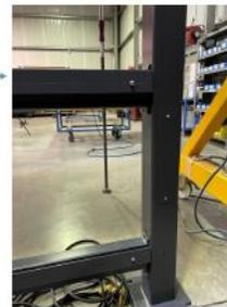
Positionner les 4 vis /poteau sans les serrer au maximum.
